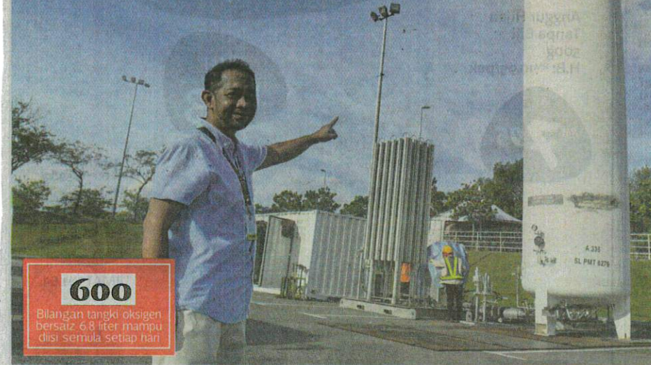
DR Shahabuddin menunjukkan tangki penyimpanan gas oksigen cecair berkapasiti 20,000 liter dengan ketinggian 50 kaki dan luas diameter 2.5 meter yang dibina di PKRC Maeps 2.0 di Serdang.
